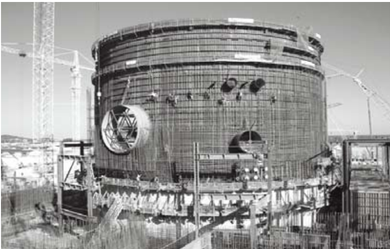
▲ 건설 중인 신고리 핵발전소, 2차 에너지기본계획은 핵발전소 건설을 지속할 계획이다. (출처: 현대건설 홈페이지)
