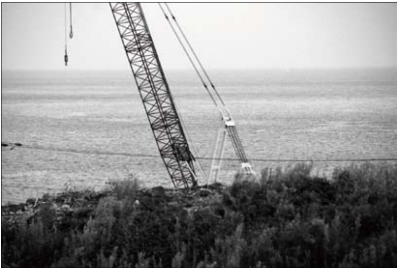
△ 제주 해군기지 건설 반대 농성장 뒷편 철재 담장 너머로 공사중인 크레인의 모습이 보인다. 해군은 10월 6일 구럼비 바위 시험발파에 이어 7일에는 콘크리트 타설 작업을 진행했다.
