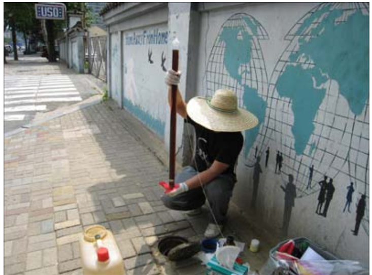
사진-1. 지하수 위에 뜬 부유기름 제거 작업 (서울시)
